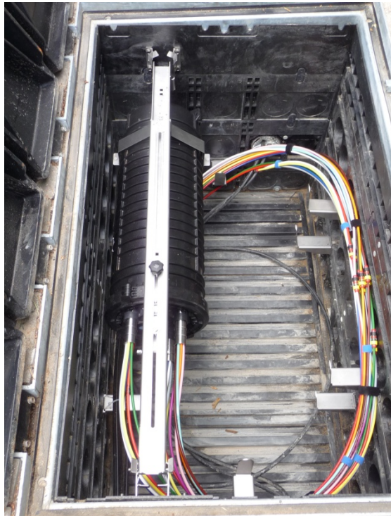
Abbildung 27: Gf-NVt unterirdisch
