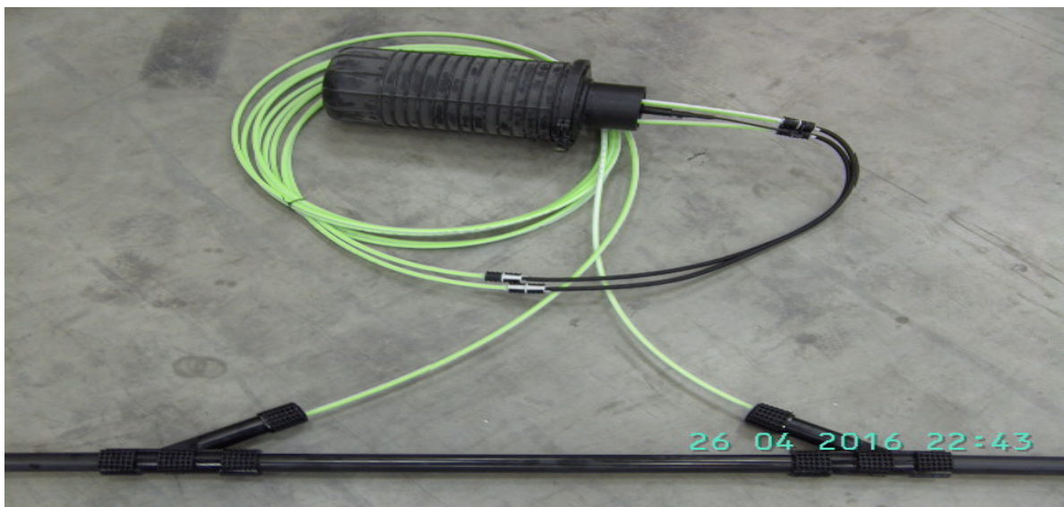
Abbildung 25: Richtige Gf-Muffenmontage mit Y-Abzweiger und PPWR
